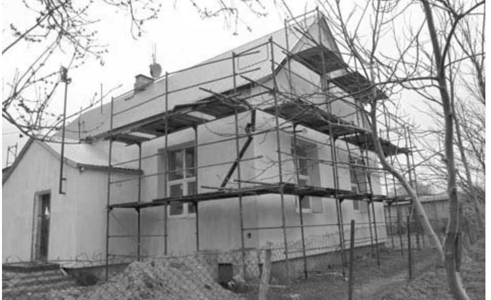
Trwa remont świetlicy w Kurianach
