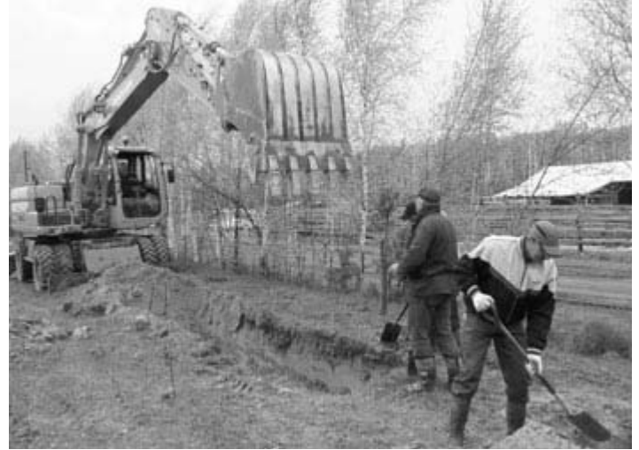
Początek układania wodociągu w Koźlikach
