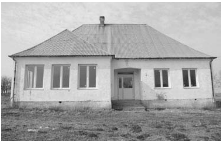
Wstawiono już nowe drzwi i okna w świetlicy w Folwarkach Małych
