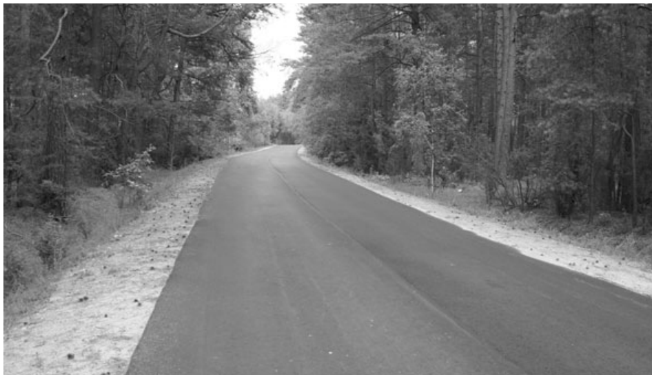
Nowa nawierzchnia na fragmencie drogi Krynickie - Zabłudów
