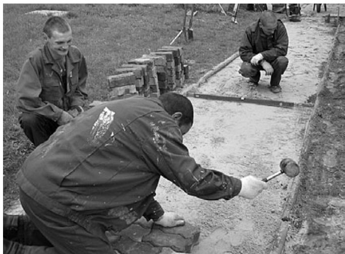
Pierwsze prace przy układaniu chodnika
