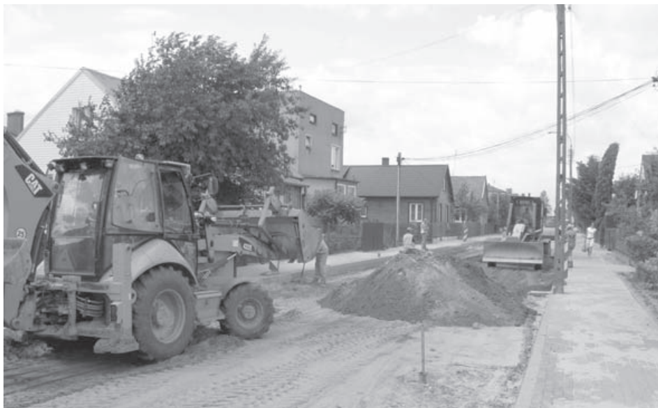
Trwają prace na ulicy
