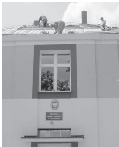
PW Robotnicy na dachu
