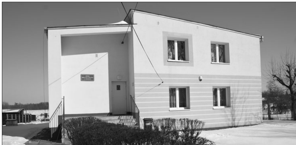
Budynek zabłudowskiej biblioteki
