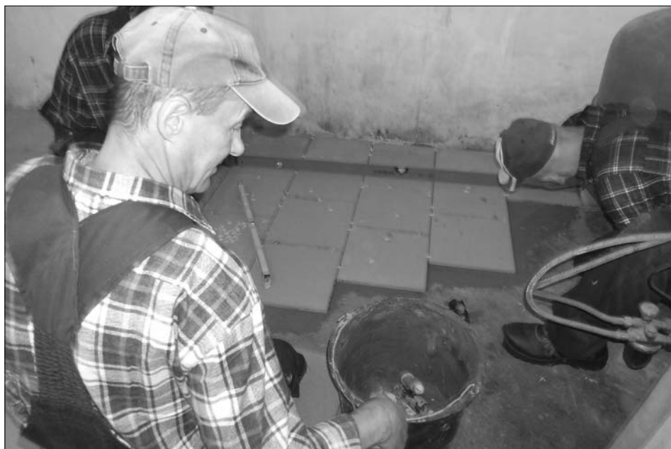
Układanie posadzki w kotłowni Urzędu Miejskiego w Zabłudowie ramach szkolenia „Glazurnik”
