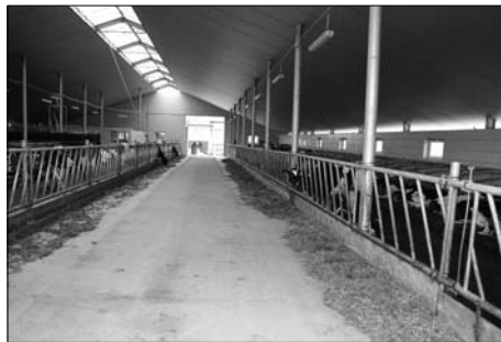
Bezpieczny ciąg komunikacyjny w oborze
