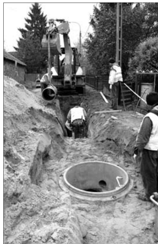
Budowa kanalizacji deszczowej w ul. Zamiejskiej
