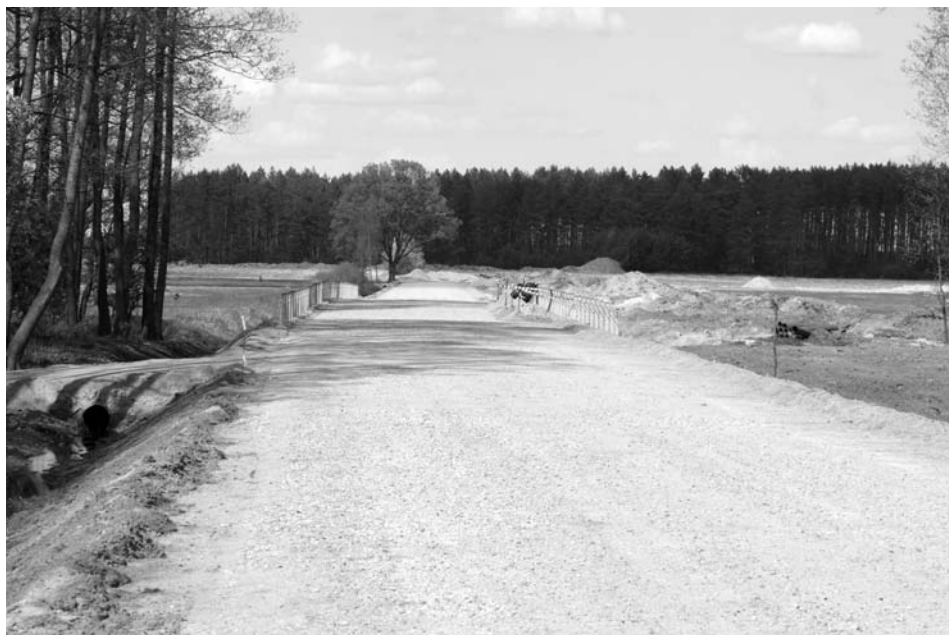
Nowo wybudowana droga do zakładów SaMASZu. W przyszłości odcinek ten zostanie przedłużony prosto do drogi krajowej.
