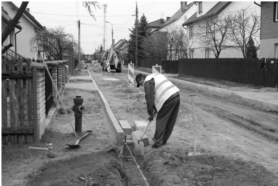
Budowa nowej nawierzchni na ul. Polnej w Zabłudowie
