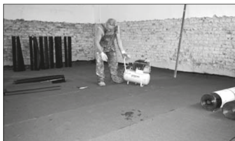
Remont pomieszczeń pod małą salą gimnastyczną w Zabłudowie
